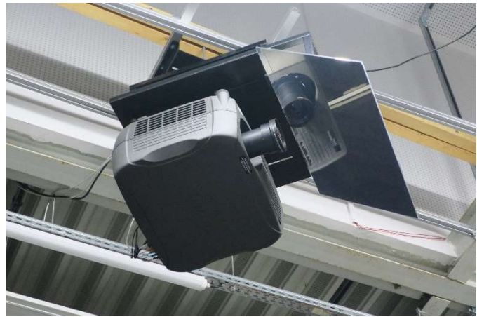
Projecteur et miroir fixés sur une plaque, elle-même fixée à la structure métallique de l'architecture de la toiture
